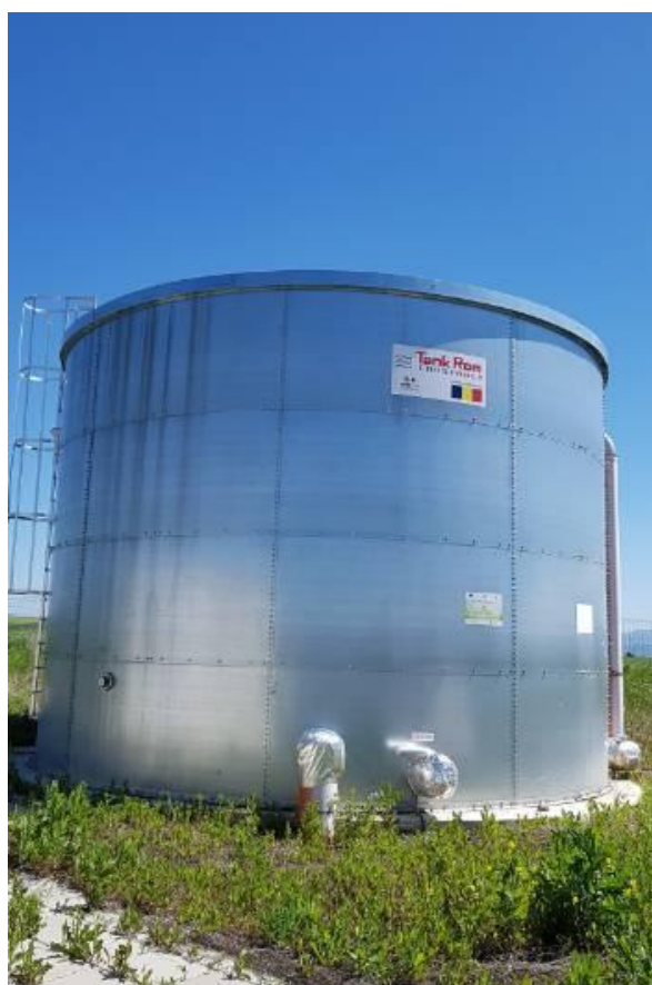
16. Rezervor cilindric suprateran de 150 mc
